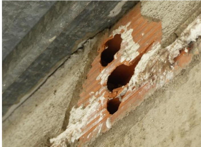
Photo 2 : Brique creuse d'un des bâtiments situés sur les toitures au sein du campus Santé susceptible d'abriter des chiroptères
